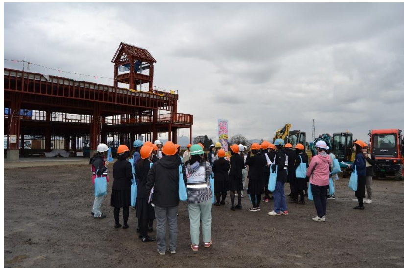
▲建設中の横手市消防署西分署を見学
