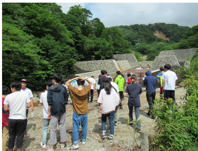
▲先達川地区山腹崩壊地砂防堰堤の見学
