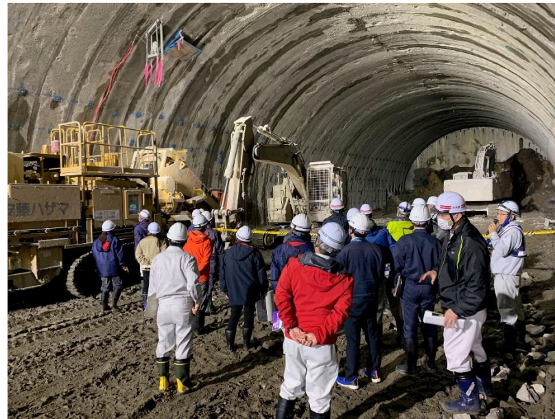
▲横堀トンネル内見学状況
