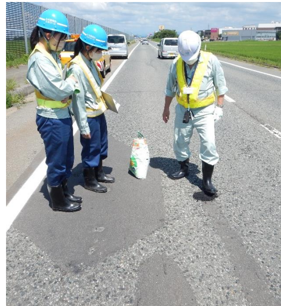
▲道路巡視体験 (写真：常温合剤での道路補修)
