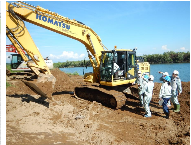
▲ICT建設機械搭乗体験 (写真：マシンガイダンスシステム搭乗)
