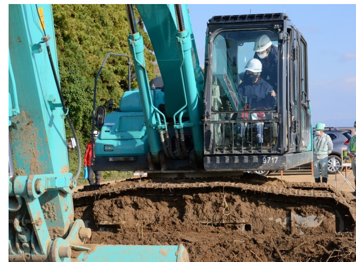
工事現場見学 (ICT建設機械の搭乗体験)
