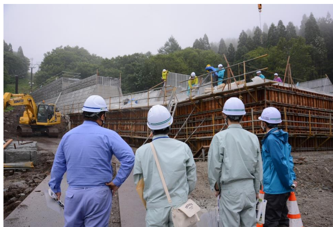
砂防事業(砂防堰堤・建設現場見学)
