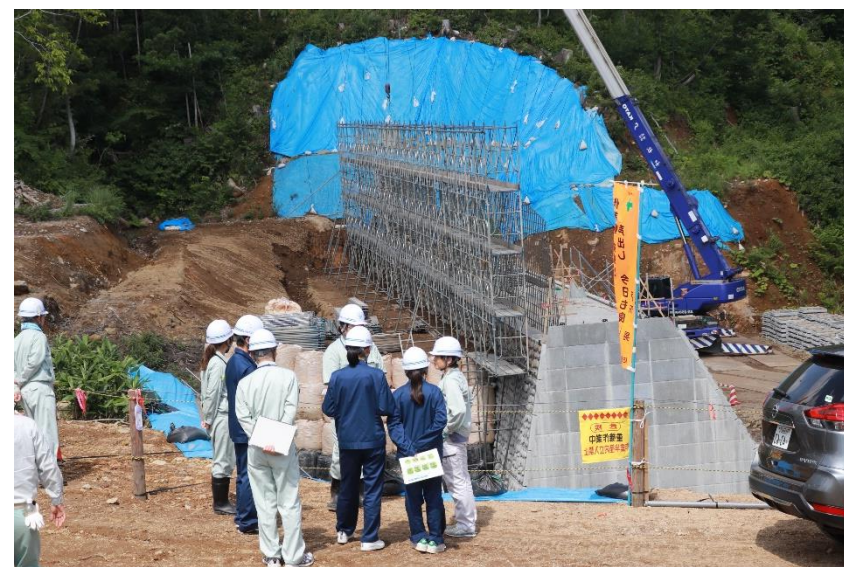
▲2日目：砂防：砂防工事現場の見学
