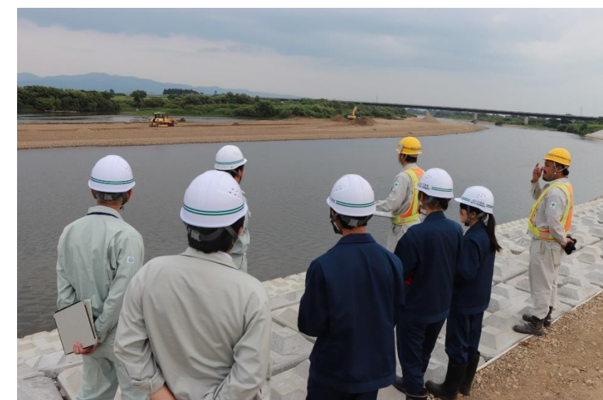
▲3日目：河川：河川工事現場の見学
