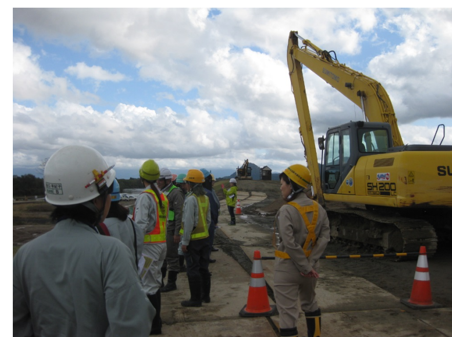
▲現場の安全パトロールの状況
