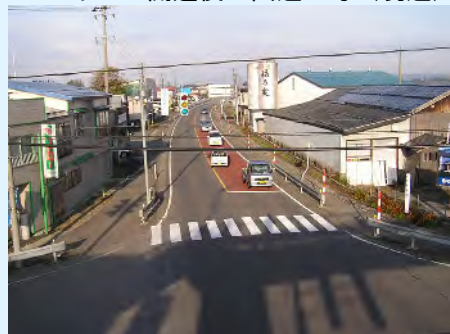
▼バイパス開通後の国道13号 (現道)
