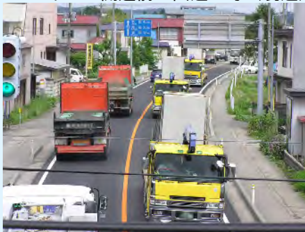
▼バイパス開通前の国道13号 (現道)
