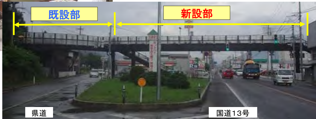
連結した横断歩道橋
