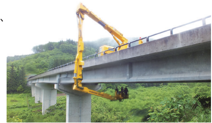
橋梁定期点検
