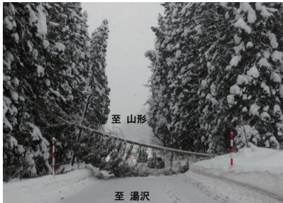
令和2年12月18日 国道13号 降雪による倒木状況
