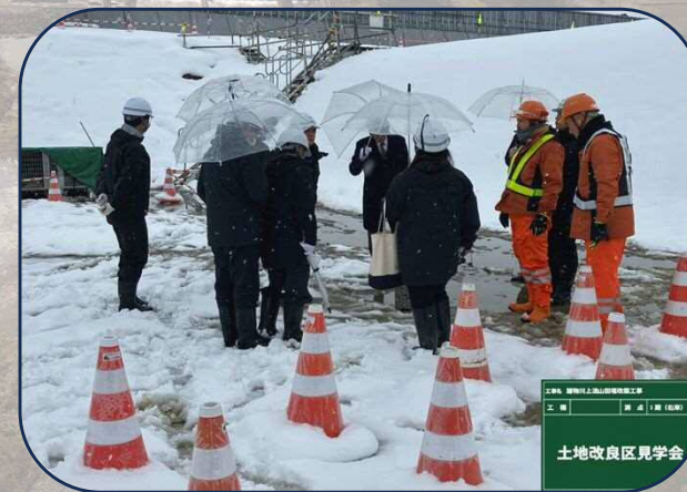
撤去した既設固定堰の 一部をご覧の様子
