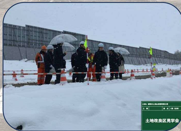
現場作業説明の様子
