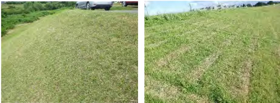
写真 1-1 ノシバで被覆されている堤防法面
