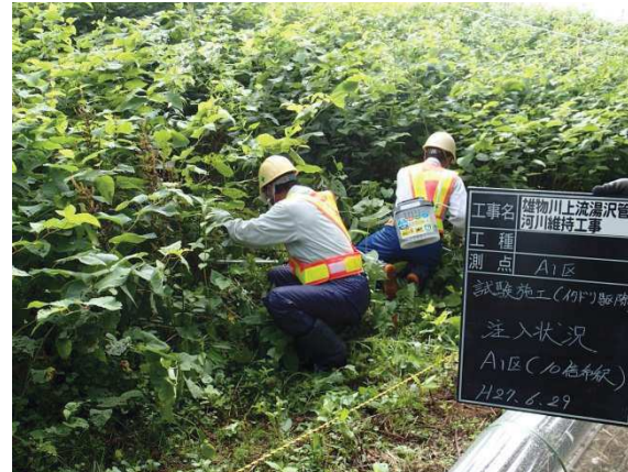
除草剤注入作業中
