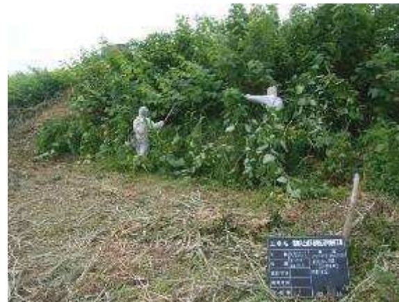
除草剤注入作業中
