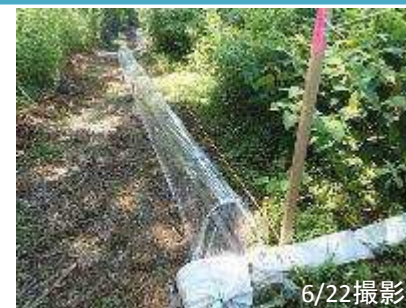
雨樋への直接の降雨防止のため 覆いを設置(A1)
