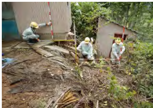
地元測量業者による現地調査状況
