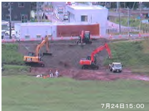
本復旧実施状況
