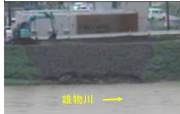
応急復旧(抑え砕石投入+袋詰め根固め工)完了
