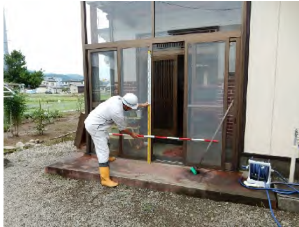
浸水深調査状況
