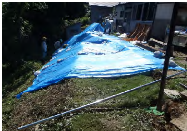
応急措置状況
