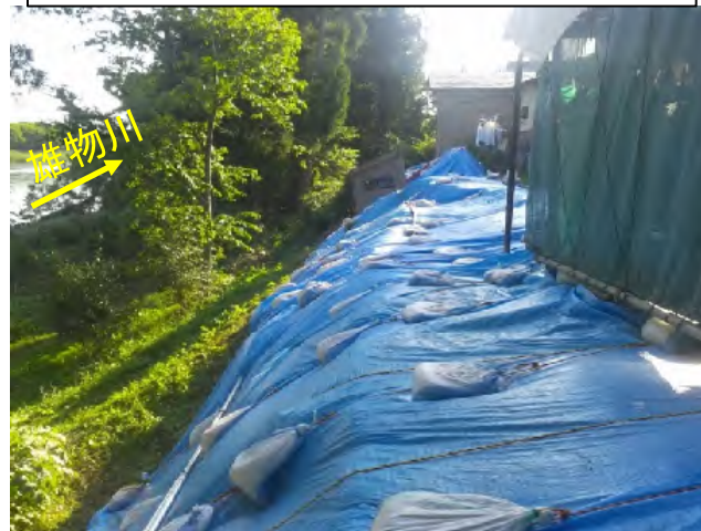
応急措置完了: 8月2日16:05
