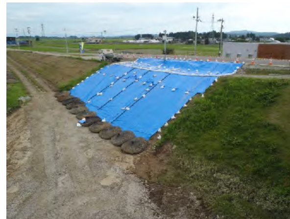
本復旧完了状況
