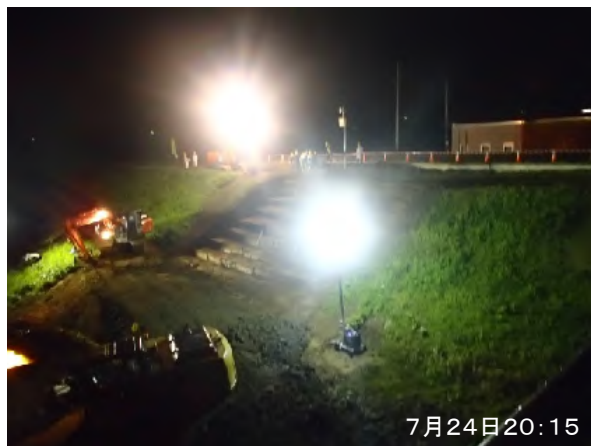
夜間の本復旧実施状況
