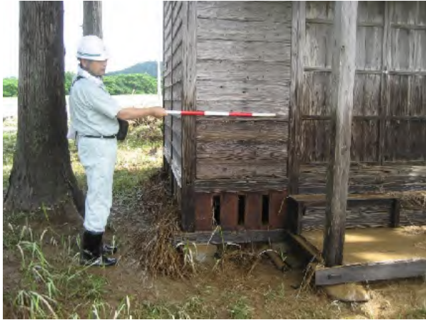
浸水深調査状況
