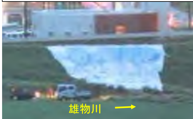
応急復旧(ブルーシート張り)完了
