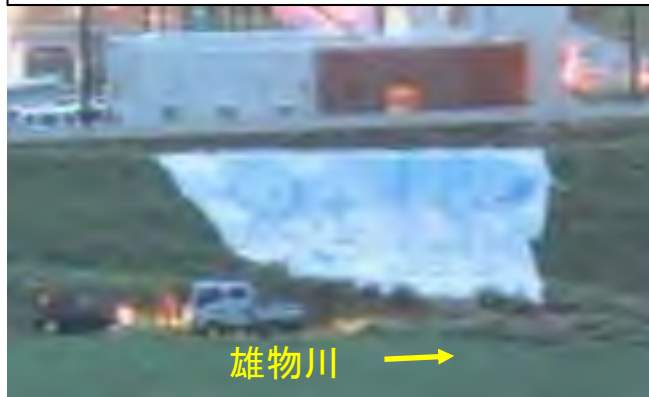
応急復旧(ブルーシート張り)完了
