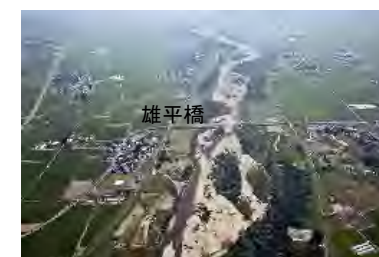
支川皆瀬川の斜め写真
