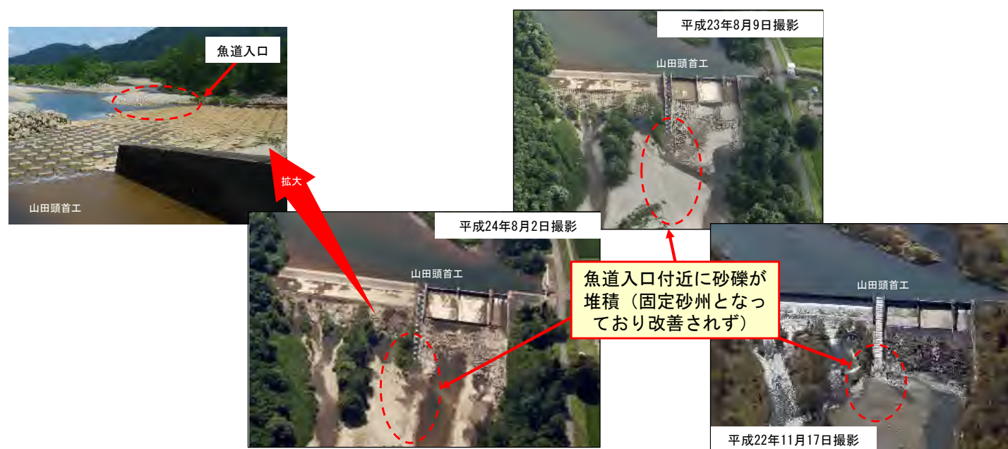
図 4.3.9 対策箇所現況(目標③)
