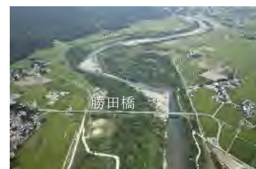
支川玉川の斜め写真
