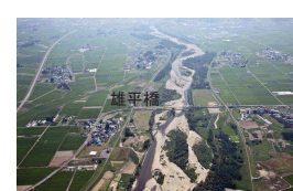
支川皆瀬川の斜め写真
