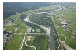
支川玉川の斜め写真
