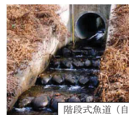
図 5.3.8 河道と堤内地との連続性の確保の事例（小貝川）
