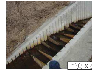
図 5.3.8 河道と堤内地との連続性の確保の事例（小貝川）
