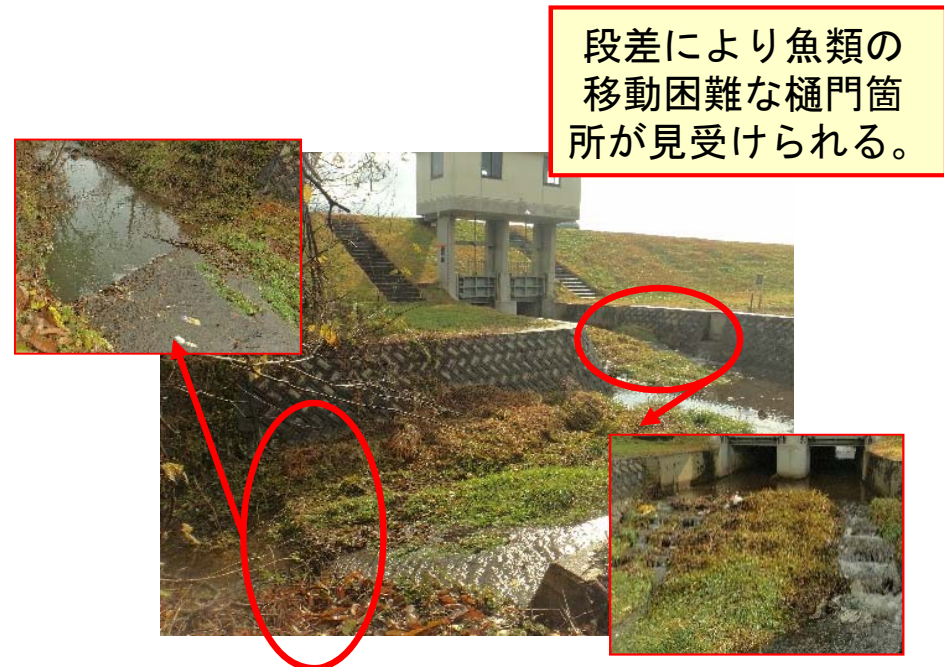
図 魚類の移動が困難となっている樋門吐口
