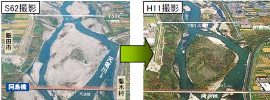
写真 礫河原の樹林化の状況(天竜川151km付近)
