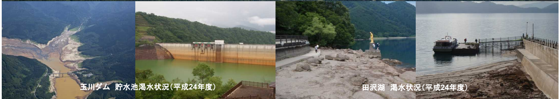
玉川ダム 貯水池渇水状況(平成24年度)
