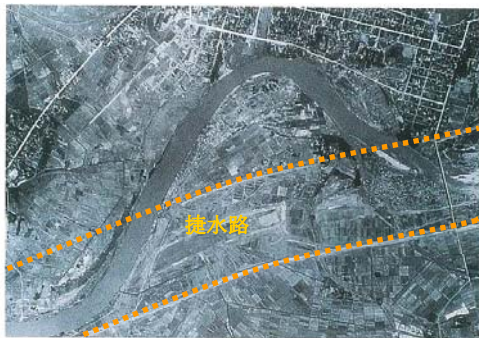
大曲捷水路改修工事中（昭和36年）
