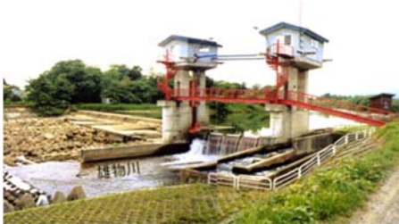
大久保頭首工（改築前）
