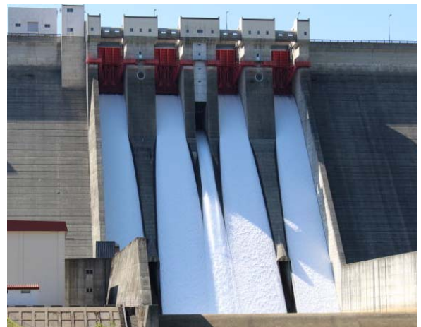
玉川ダムの試験放流の様子
