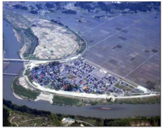
強首輪中堤（完成後）
