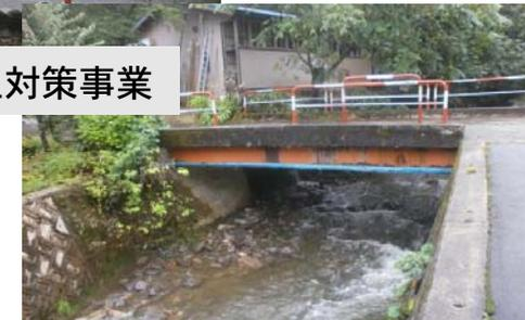
大羅迦内沢川河川改修箇所。左右の護岸高が違うため、右岸側の溢水防止のため護岸嵩上工を施工など、25事業
