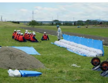
積土のう工法
