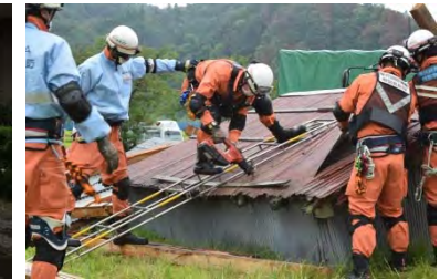
救助隊による倒壊建物からの救出
