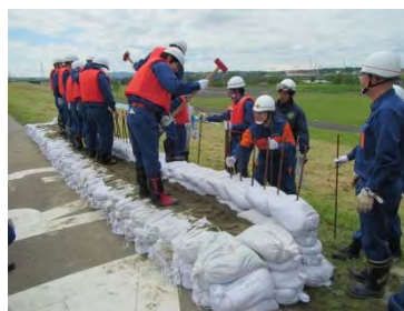
改良積土のう工法
