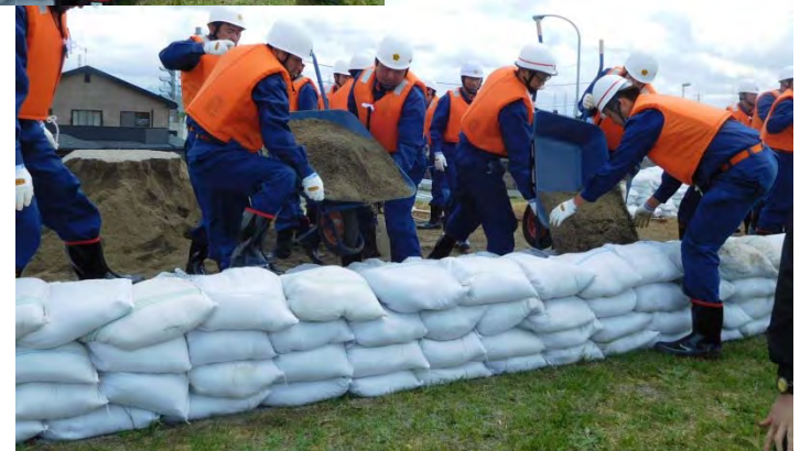
東成瀬村は「積土のう工」を実施
