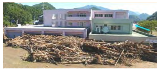
平成28年台風10号により、岩手県の要配慮者利用施設では利用者9名の全員が死亡。
