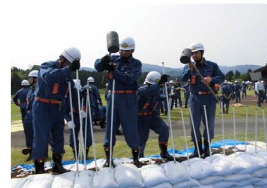
土のう積み工法
