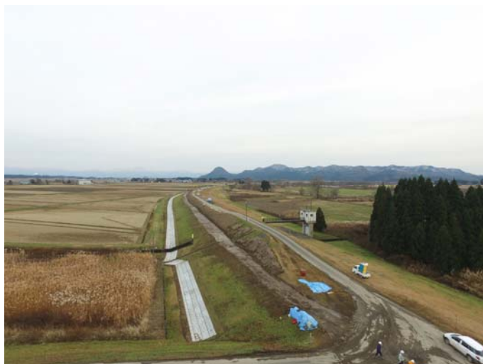
裏法尻の補強（完成後の全景）
