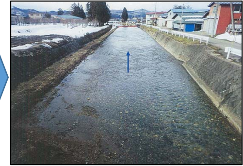
州ざらい実施完了 (H29.1.27) 合同巡視における状況確認と州ざらいの実施（駒形黒沢川）
