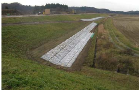
裏法尻の補強（完成後）
