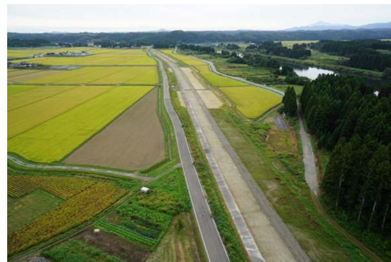
天端の保護（全景）
