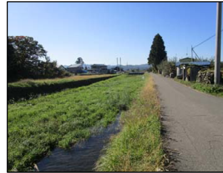
合同巡視において河川状況確認 (H28.11.7)
