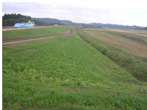
裏法尻の補強（着工前）
