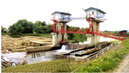
大久保頭首工（改築前）
