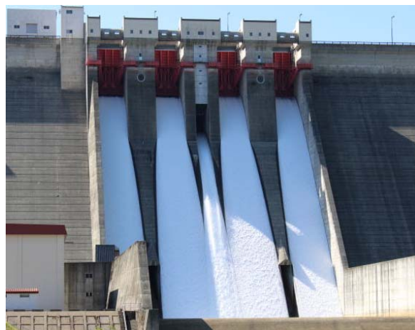
玉川ダムの試験放流の様子
