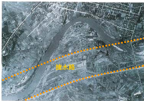
大曲捷水路改修工事中（昭和36年）
