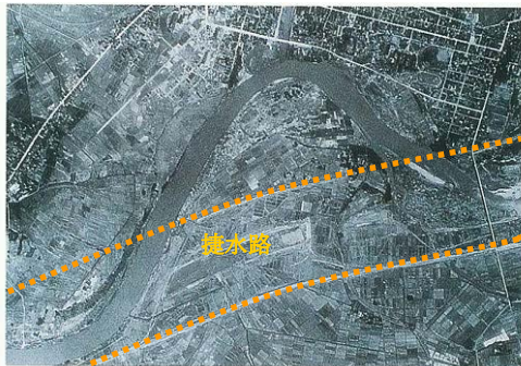
大曲捷水路改修工事中（昭和36年）
