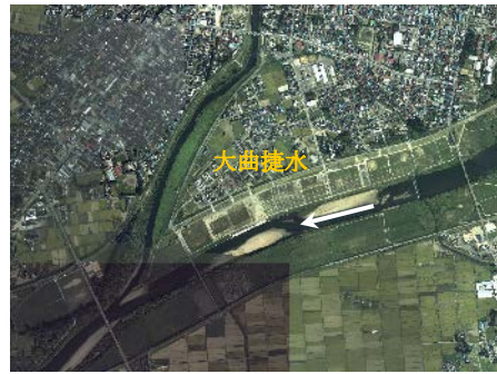
大曲捷水路完成後（平成22年）
