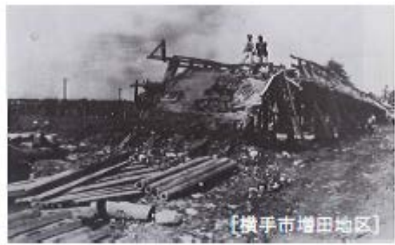
S22.7洪水時の被害状況（横手市増田地区）
