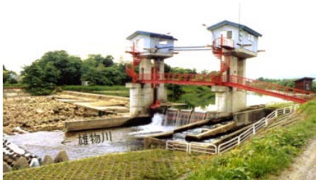
大久保頭首工（改築前）
