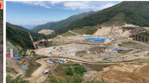
成瀬ダム 左岸側堤体面打設中状況
