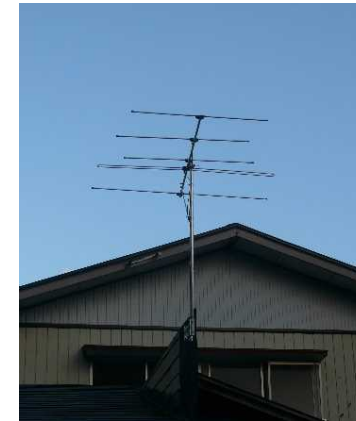
個別アンテナの設置
