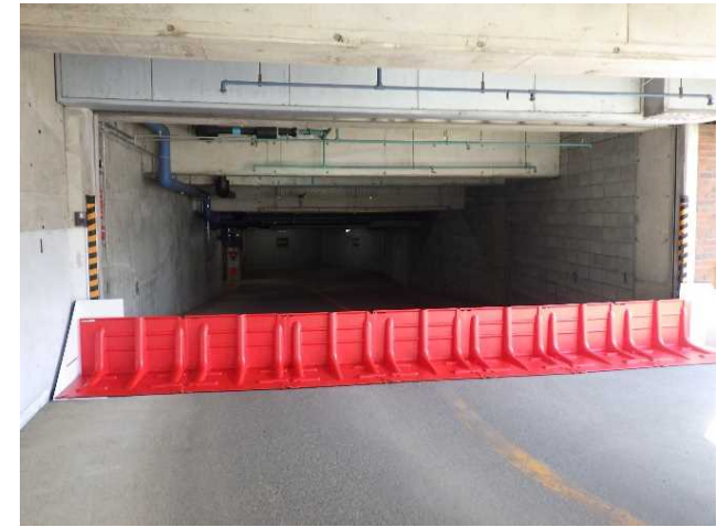
本庁地下駐車場入り口への「止水板」設置状況
