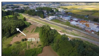
堤防完成 (令和元年9月25日撮影)
