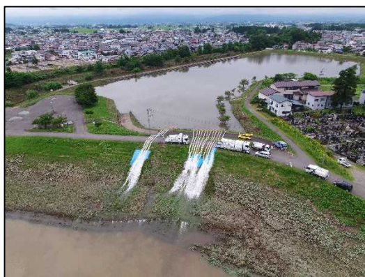
排水ポンプ車による排水作業（大仙市）
