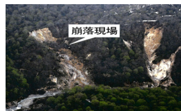
先達川被害状況（平成9年）
