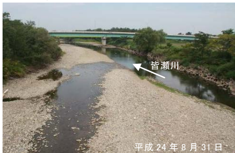
⑤ 岩崎橋地点の状況(平成24年8月:横手市、湯沢市)
