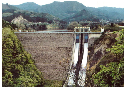
皆瀬ダム (昭和 38 年完成)
