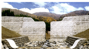
黒沢第1砂防堰堤
