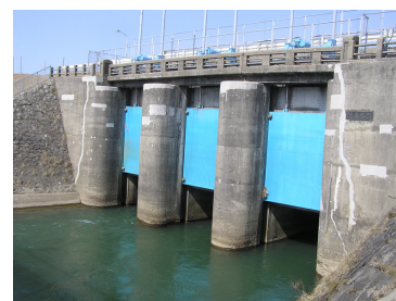
新屋水門（改築前）
