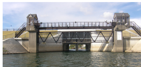
新屋水門（改築後）
