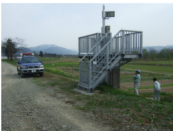
河川巡視(平常時)の状況
