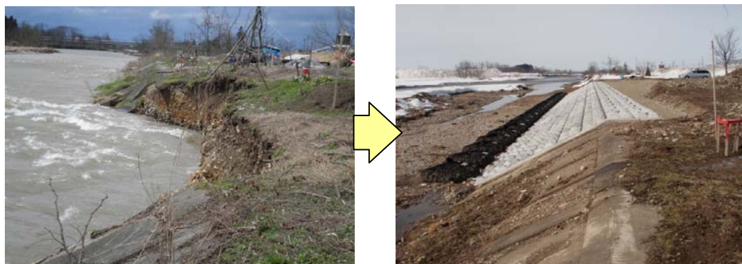
護岸の損傷
