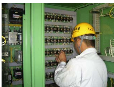
機側操作盤の点検状況
