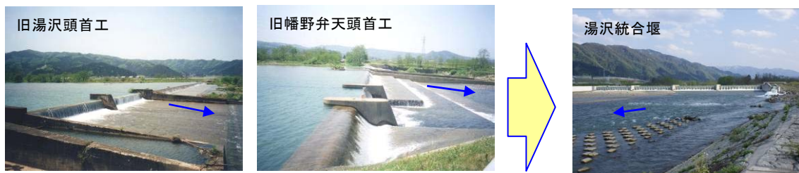
湯沢頭首工改修前後の施設状況
