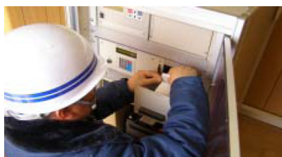
観測所保守点検状況
