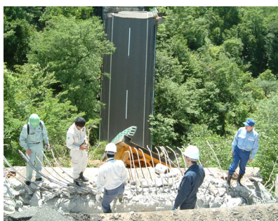
TEC-FORCEの派遣状況 岩手・宮城内陸地震 (平成20年6月14日)
