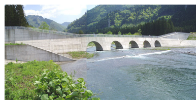
生保内川大暗渠砂防堰堤
