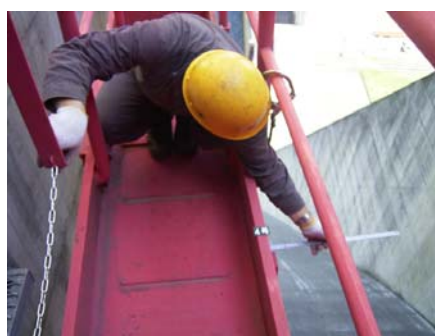
放流設備点検状況
