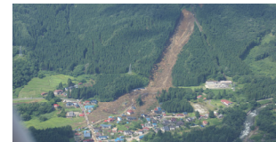
供養佛地区被害状況（平成25年）
