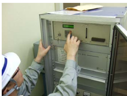
観測施設の点検状況
