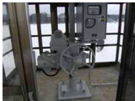
ゲート開閉装置の更新（手動 電動）
