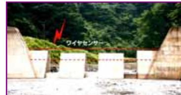
土砂移動検知センサー
