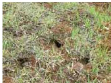
堤防変状状況（車輻による損傷、モグラ穴）
