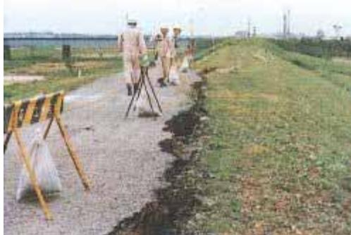
日本海中部地震で発生した堤防の亀裂・沈下状況（秋田市牛島地区）
