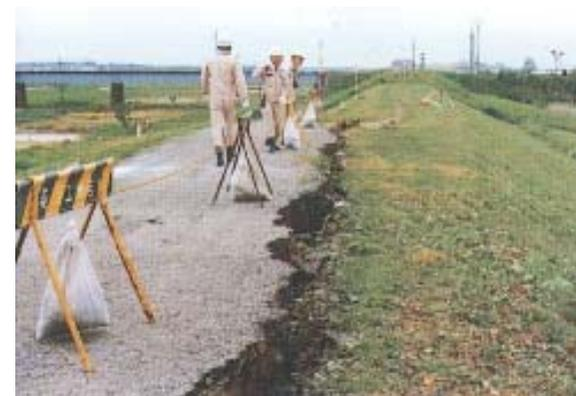
日本海中部地震で発生した堤防の亀裂・沈下状況（秋田市牛島地区）
