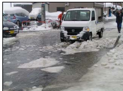
流雪溝が閉塞し駅前通りが冠水
