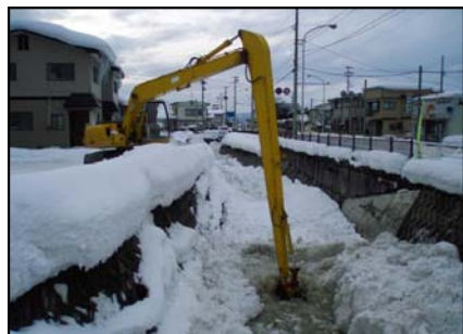
水不足で閉塞した 中小河川の復旧状況
