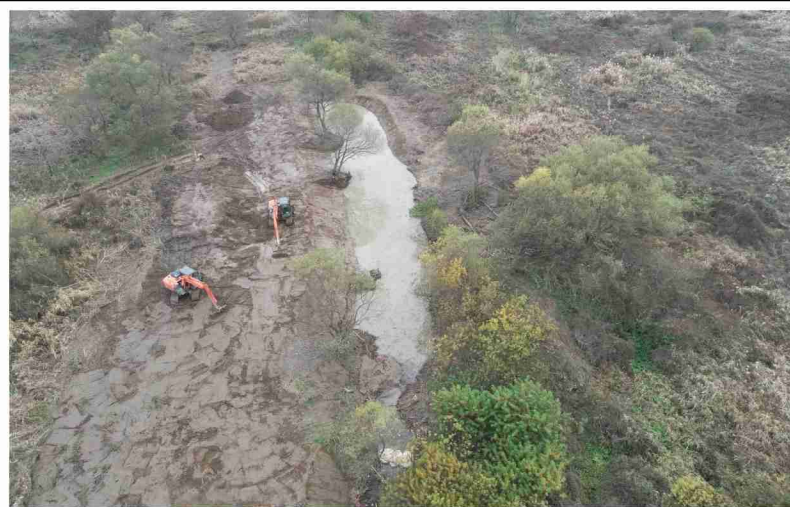
ワンドの掘削土を法面・法肩に貼り付け現場内利用
