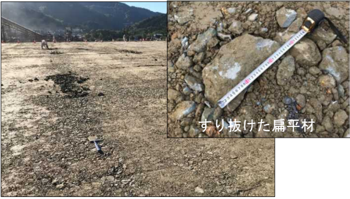
80mm超過材料の密集状況
