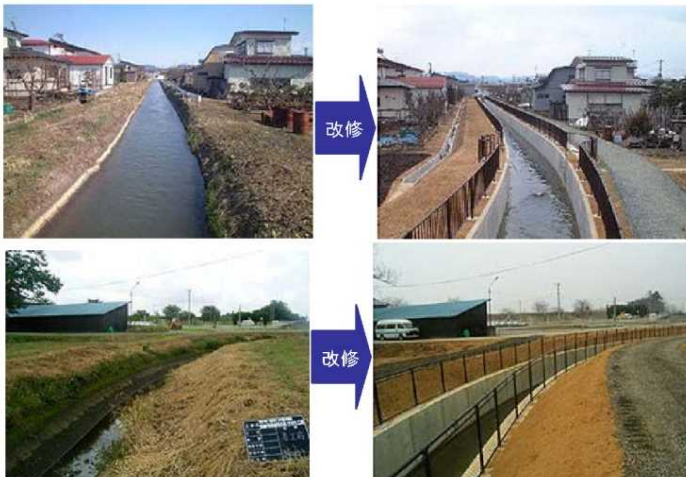
幹線用水路整備状況
