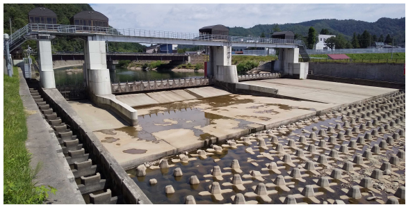
成瀬頭首工の状況 R3.7.26
