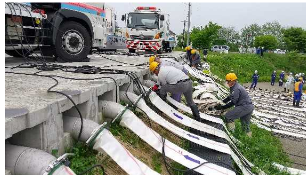
排水ホース設置状況
