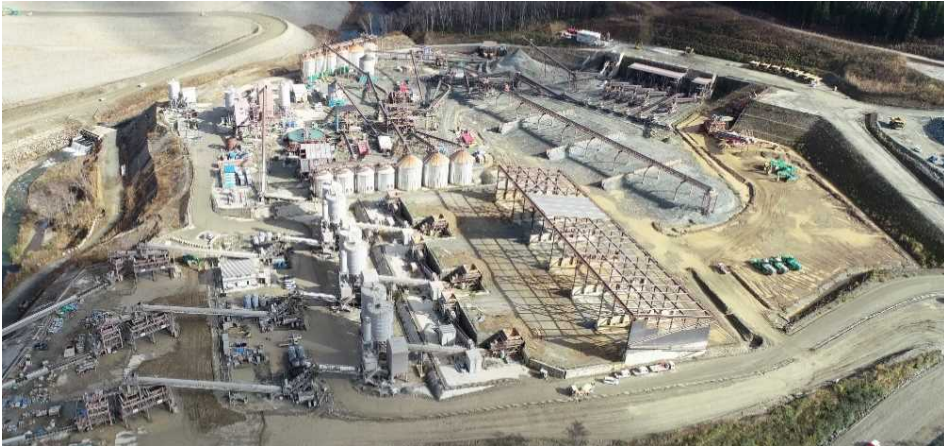
仮設備の設置状況
