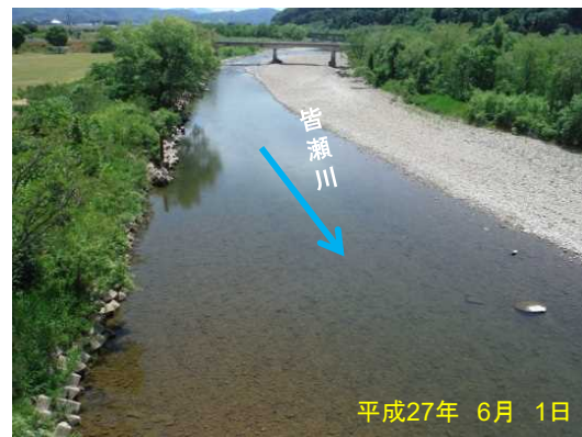
正常流量2.8m 3 /秒 流下状況
