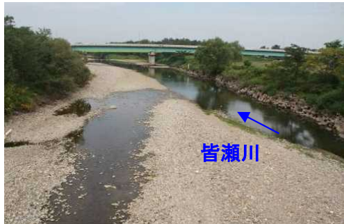
岩崎橋地点の状況 (平成24年8月:横手市、湯沢市)
