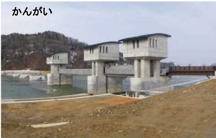
皆瀬頭首工 (H21.3竣工 東北農政局)
