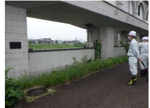
福部内川水門の遠隔・機側操作状況
