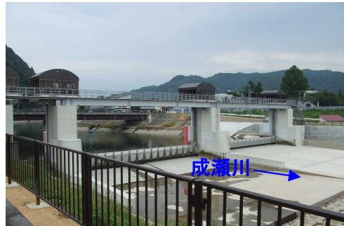
成瀬頭首工地点の状況 (平成24年8月:横手市)
