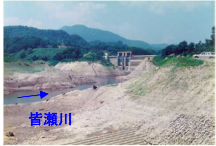
枯渇する皆瀬ダム(平成6年8月:湯沢市)
