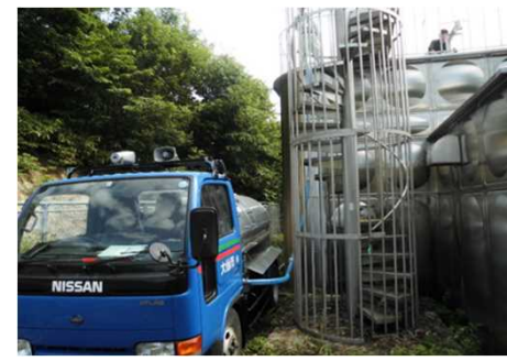
南外地区配水池への補給状況 R1.7.17
