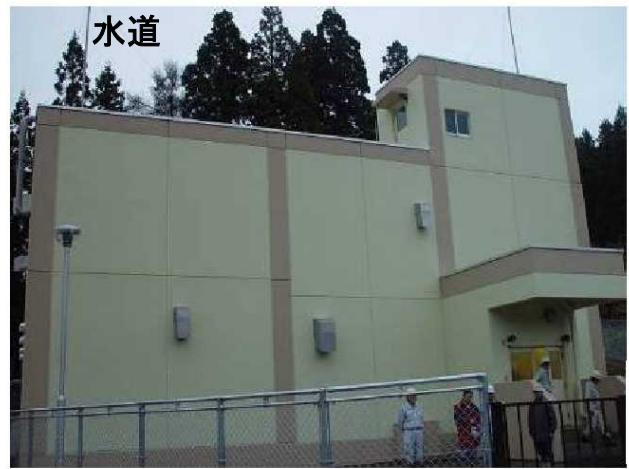
大沢郷地区簡易水道 (H23竣工 大仙市)
