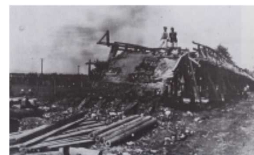
浸水状況(横手市 増田地区)
