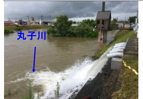
平成29年7月洪水（大仙市浜町地区） 排水ポンプ車での排水状況
