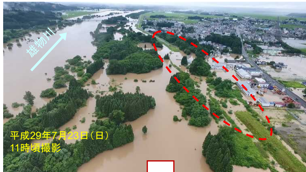
■ H29.7洪水時と堤防完成時の比較
