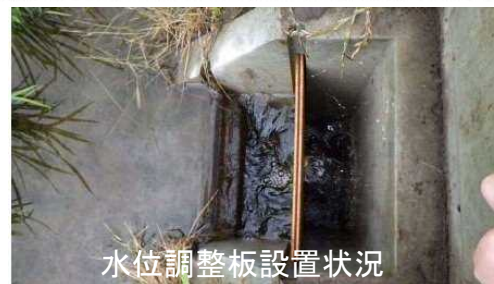
降雨後の排水状況（貯留効果確認）
