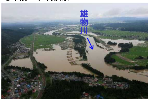
浸水状況(大仙市 中村芦沢地区)
