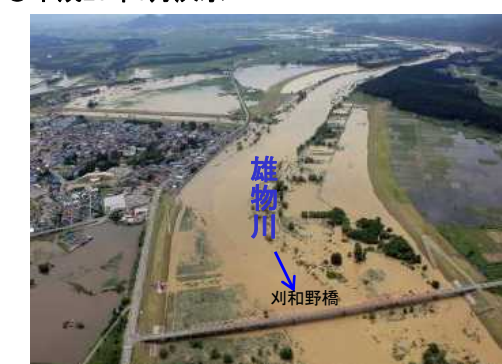
浸水状況(大仙市 刈和野地区)
