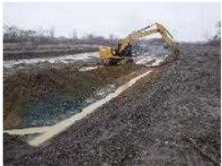
河道掘削 (石狩川水系、北海道開発局)
