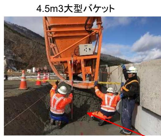
厚さ1.6mの試験施工状況写真
