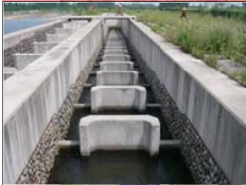
アイスハーバー式魚道(※湯沢統合堰の例)
