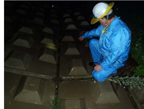
▲ 防災エキスパートによる 河川管理施設の現地確認
