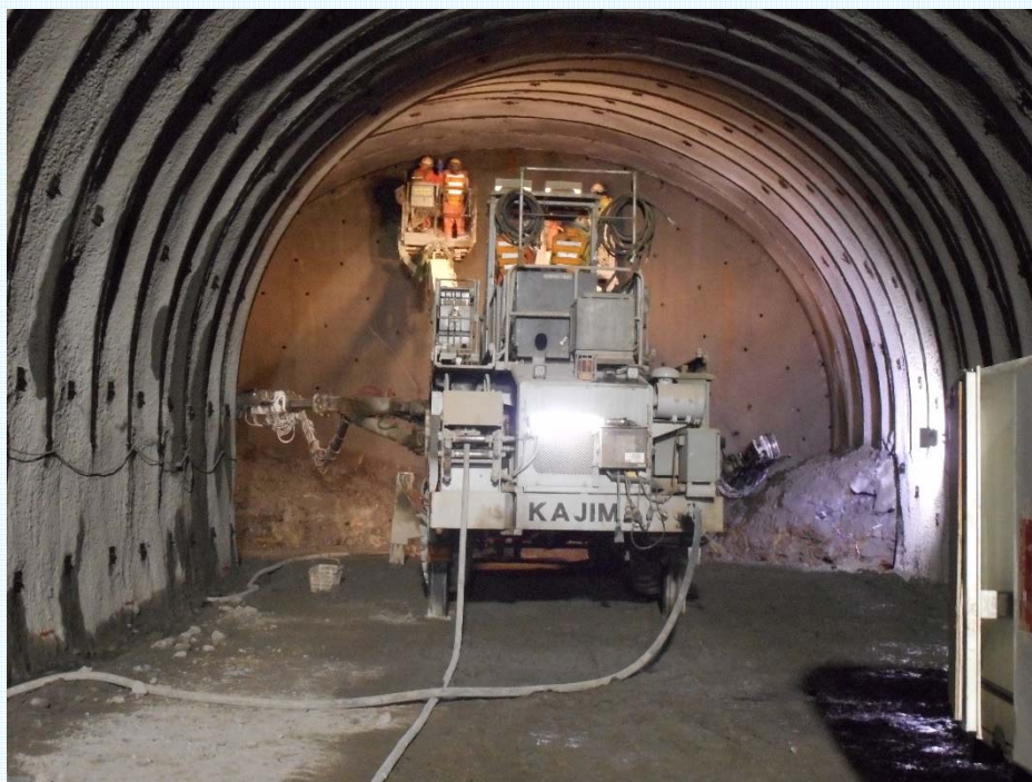
【掘削作業状況】
