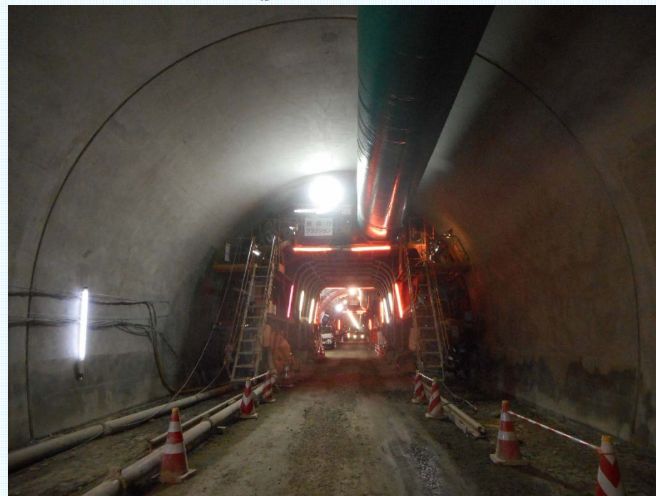
【覆工作業状況】
