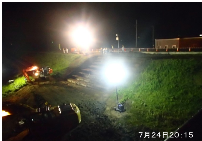
夜間の本復旧実施状況
