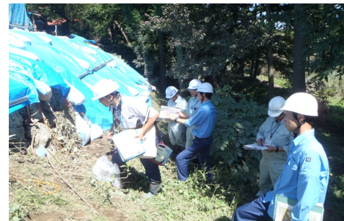
専門家による現地調査状況
