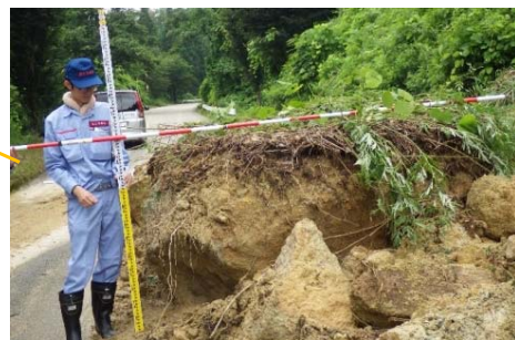
▲二井山上溝線調査状況(横手市)
