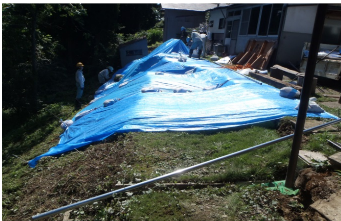
応急措置状況
