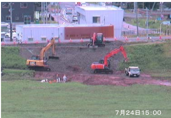
本復旧実施状況
