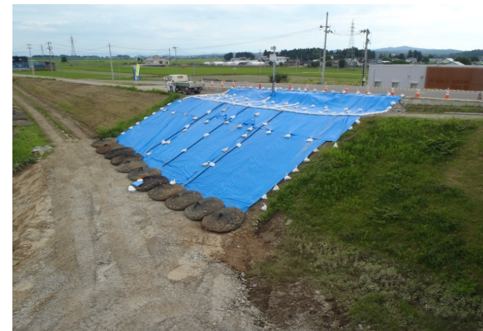
本復旧完了状況
