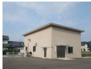
まつざわがわ 松沢川揚水機場
