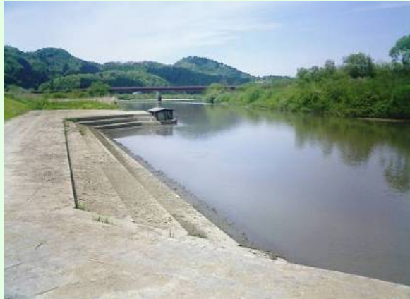
【水辺整備】親水護岸(雄物川丸子川地区)
