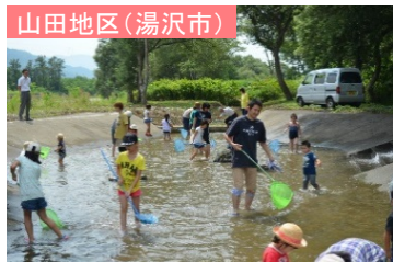
管理用通路、親水護岸、緩傾斜堤防等
