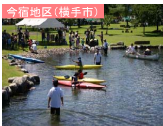
管理用通路、高水敷整正、親水護岸等
