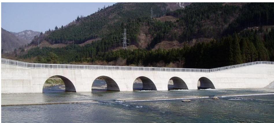
大暗渠砂防堰堤（平成18年2月完成）
