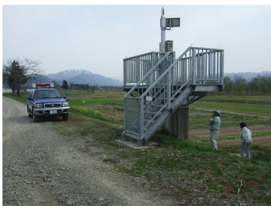
河川巡視(平常時)の状況
