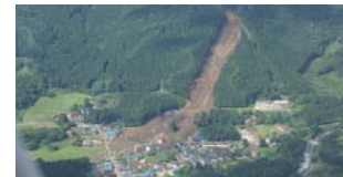
供養佛地区被害状況（平成25年）
