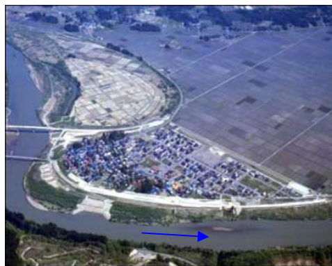
強首輪中堤（完成後）
