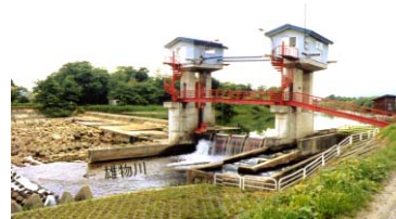
大久保頭首工（改築前）
