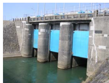
新屋水門（改築前）
