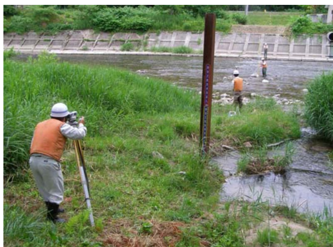
河川横断測量の様子
