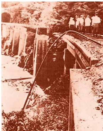
昭和35年の土砂災害（JR田沢湖線被害状況）
