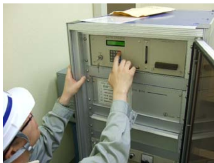
観測施設の点検状況
