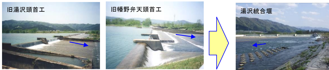
湯沢頭首工改修前後の施設状況
