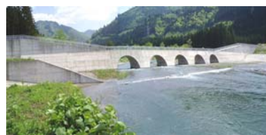
生保内川大暗渠砂防堰堤
