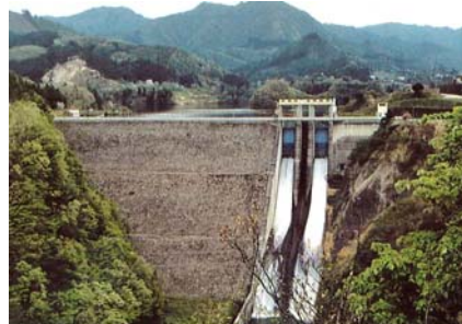
皆瀬ダム (昭和 38 年完成)
