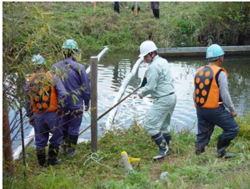
オイルフェンス設置訓練実施状況
