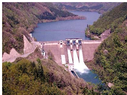
鎧畑ダム (昭和 32 年完成)
