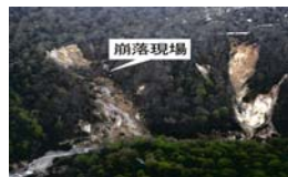
先達川被害状況（平成9年）
