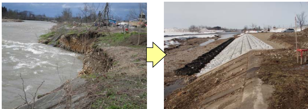
護岸の損傷
