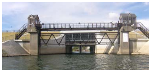
新屋水門（改築後）
