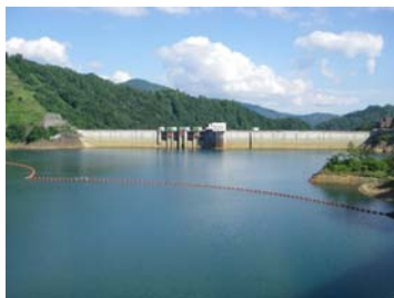
玉川ダム 流木止施設
