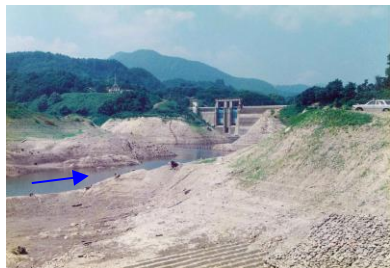
枯渇する皆瀬ダム(平成6年8月:湯沢市)
