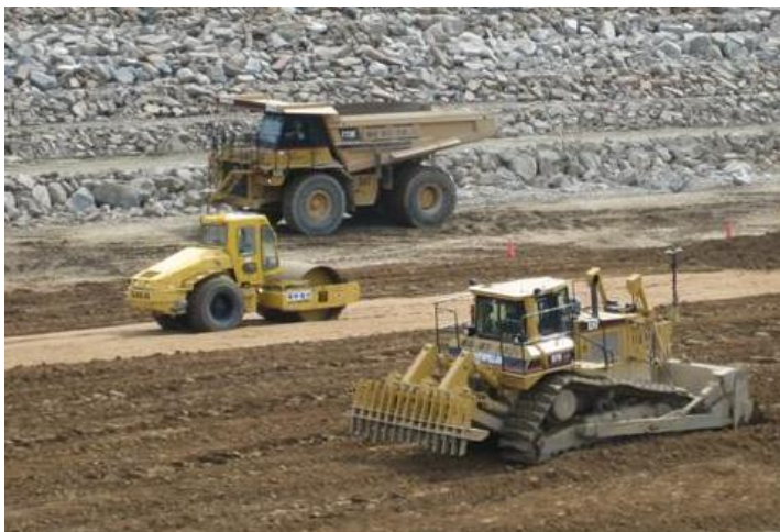
施工事例(胆沢ダム)
