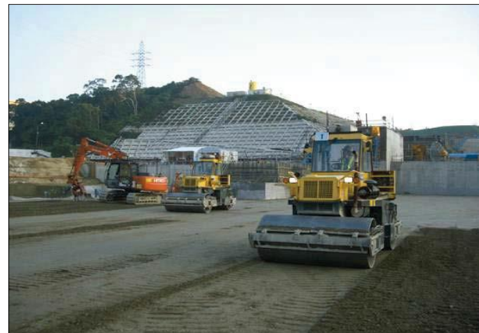
施工事例(金武ダム)
