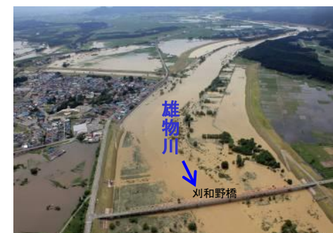
浸水状況(大仙市 刈和野地区)
