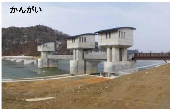
皆瀬頭首工 (H21.3竣工 東北農政局)
