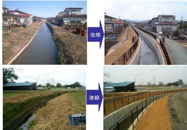
幹線用水路整備状況
