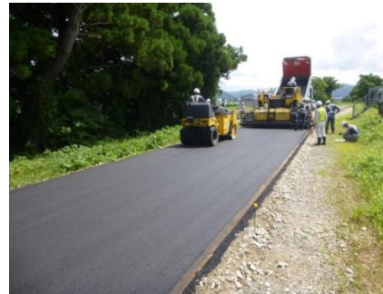
のり肩対策(天端舗装)
