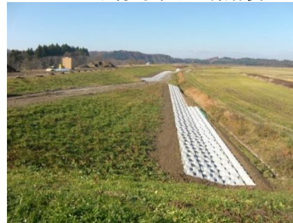
のり尻対策(コンクリートブロック張り)
