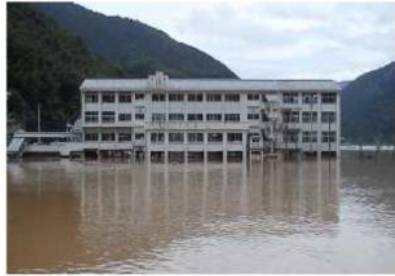
H26. 8 避難所2階の浸水(徳島県)
