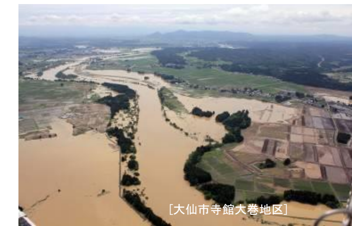
平成23年6月洪水 [大仙市寺館大巻地区]
