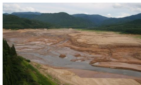
4 玉川ダム貯水池の状況 (H24.9.3撮影)
