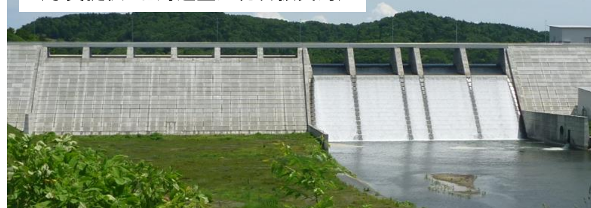
台形CSGダムの参考事例 (写真提供:北海道空知総合振興局)
